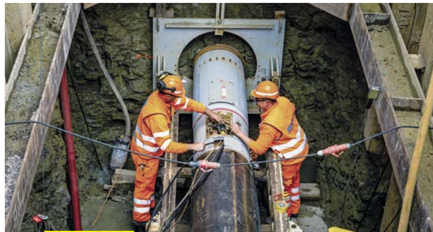
Grabenloser Leitungsbau
