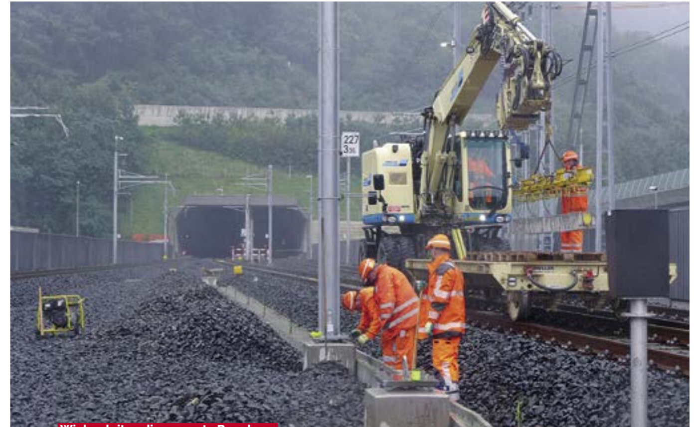
Wir begleiten die gesamte Bauphase
